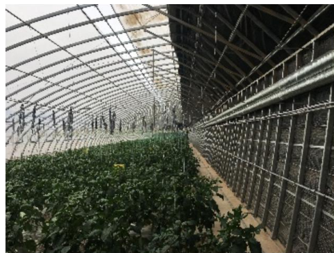
装配式砂石墙体温室
